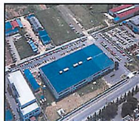
郡山ヒロセ電機(株) (福島県郡山市)
