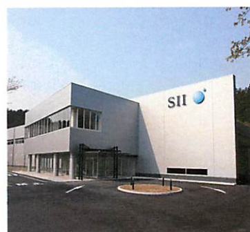
栃木本社ビル
