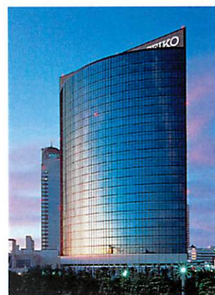
幕張本社ビル
