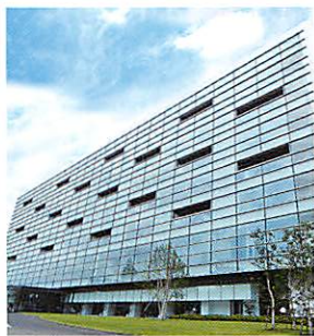
藤沢工場 新事務棟
